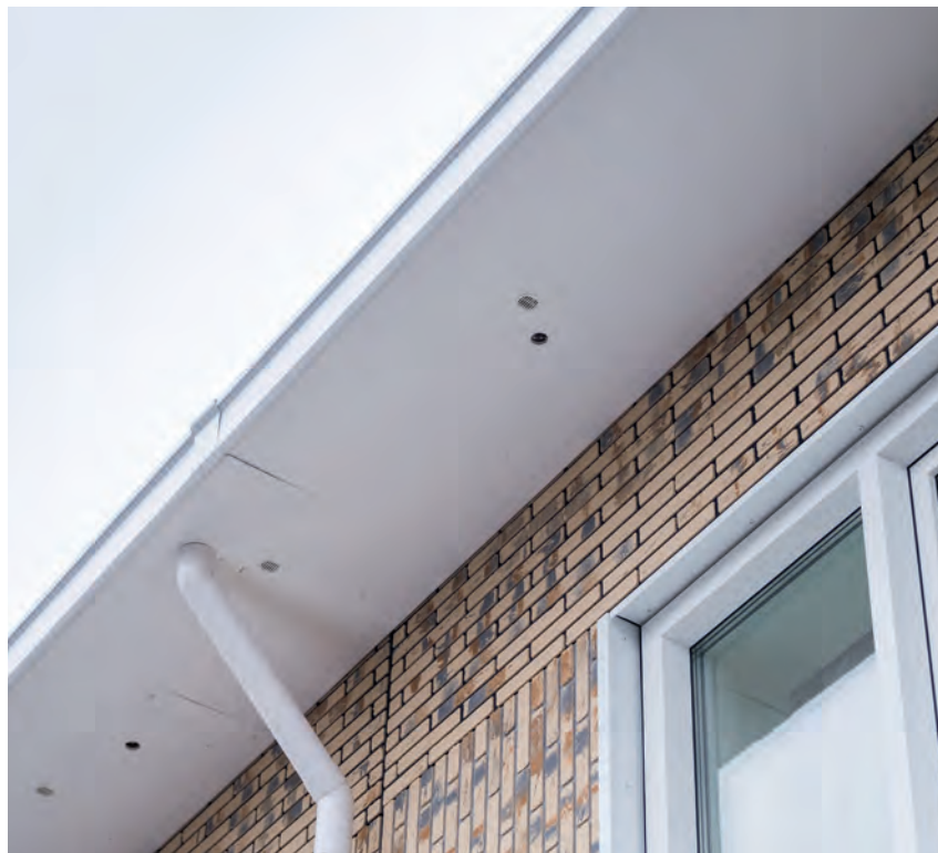
BAM Wonen heeft aan de zwaluwen en mussen gedacht: de vogels kunnen via kleine ronde gaatjes in de dakgoten hun nestkastjes bereiken.
